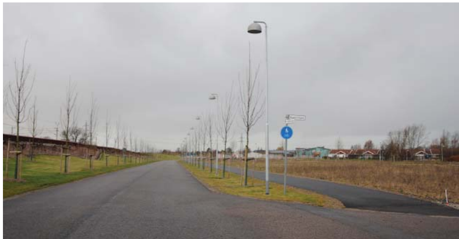
N. Stationsv., V. Ingelstad: Nybyggd gata med helt separerad gc-trafik gör att den dimensionerande trafiksäkerhetssituationen har bedömts som bil/bil - korsande kurs.
