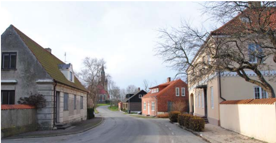
Köpmannavägen, Södra Håslöv: Längs merparten av sträckan är bebyggelsen gles och har därför bedömts som integrerat transportrum, precis som golvet. I just den punkt som fotot visar är dock bebyggelsen något tätare.
