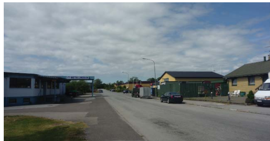
Fabriksgatan, Vellinge: Industrigata där väggar och golv bedömts som integrerat transportrum.
