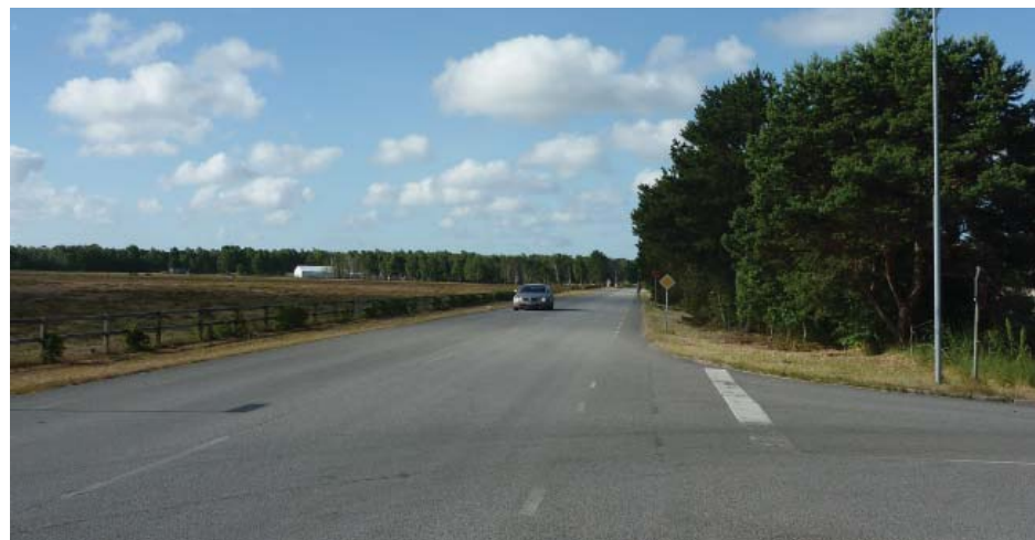
Strandbadsvägen, Falsterbo: Väggarna är transportrum och golvet integrerat transportrum
