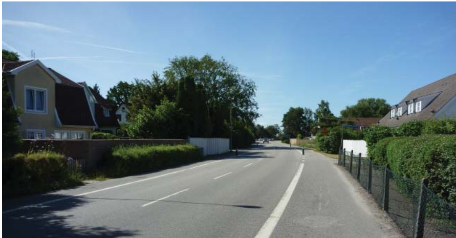
Falsterbovägen, Falsterbo: Gatans målade cykelfält har inte bedömts som tillräcklig separering för cyklister utan gatan har fått DTSS gc/bil.
