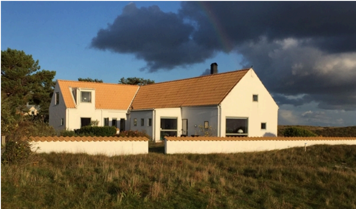
Arkitektritad villa vid Kämpingestranden som är en modern tolkning av skånelängan. Byggnaden är uppförd med traditionella material och kulörer, men har en alldeles egen fönstersättning.
