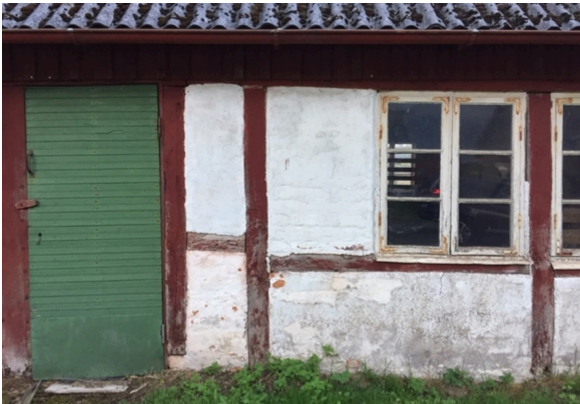
Enkel trädörr och traditionella tvåluftsfönster med fast mittpost på ett äldre skånskt bostadshus.
