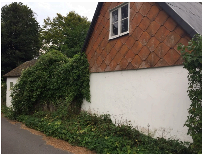
Takfoten är nätt utformad med ett utstick från fasaden på maximalt 200 mm. Gavelspetsar i olika utförande.
