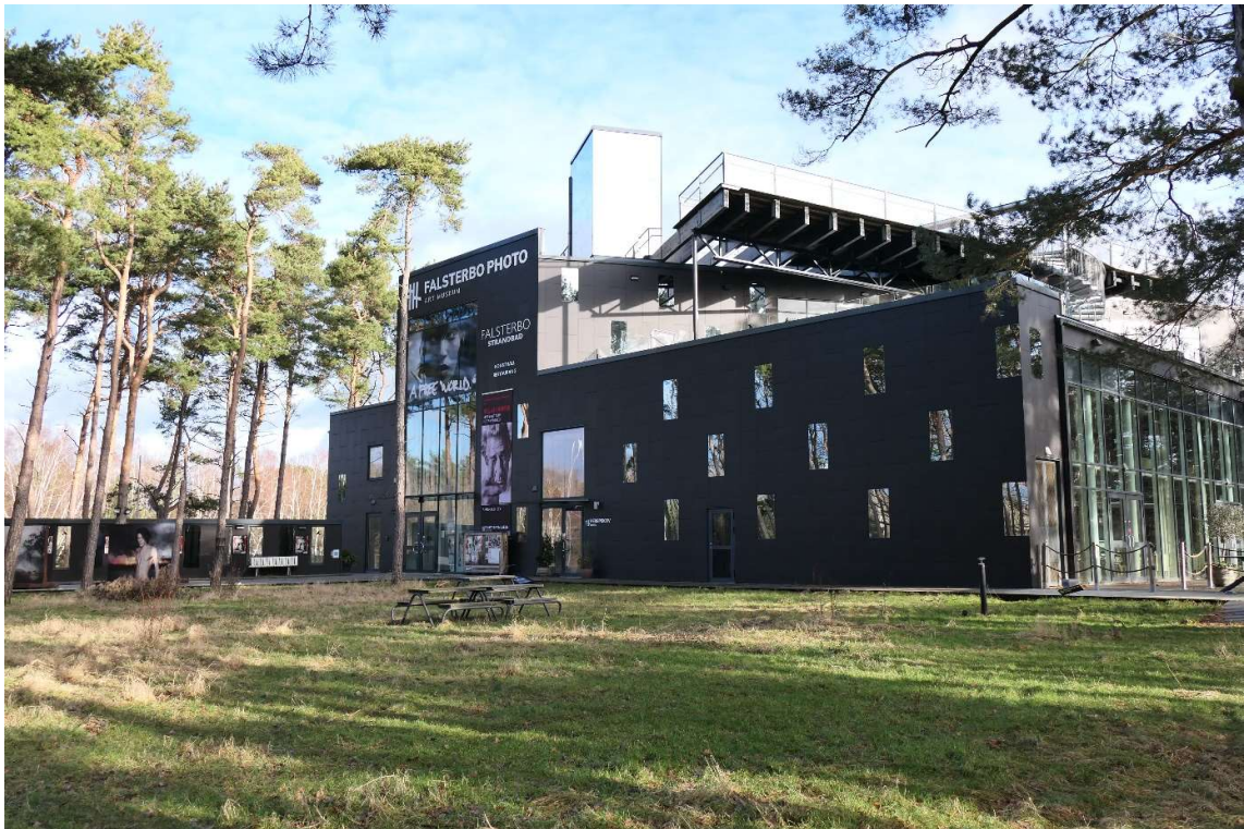
Byggnadens sydvästra hörn. Utsiktbryggan och hisstoppen framträder tydligt.
