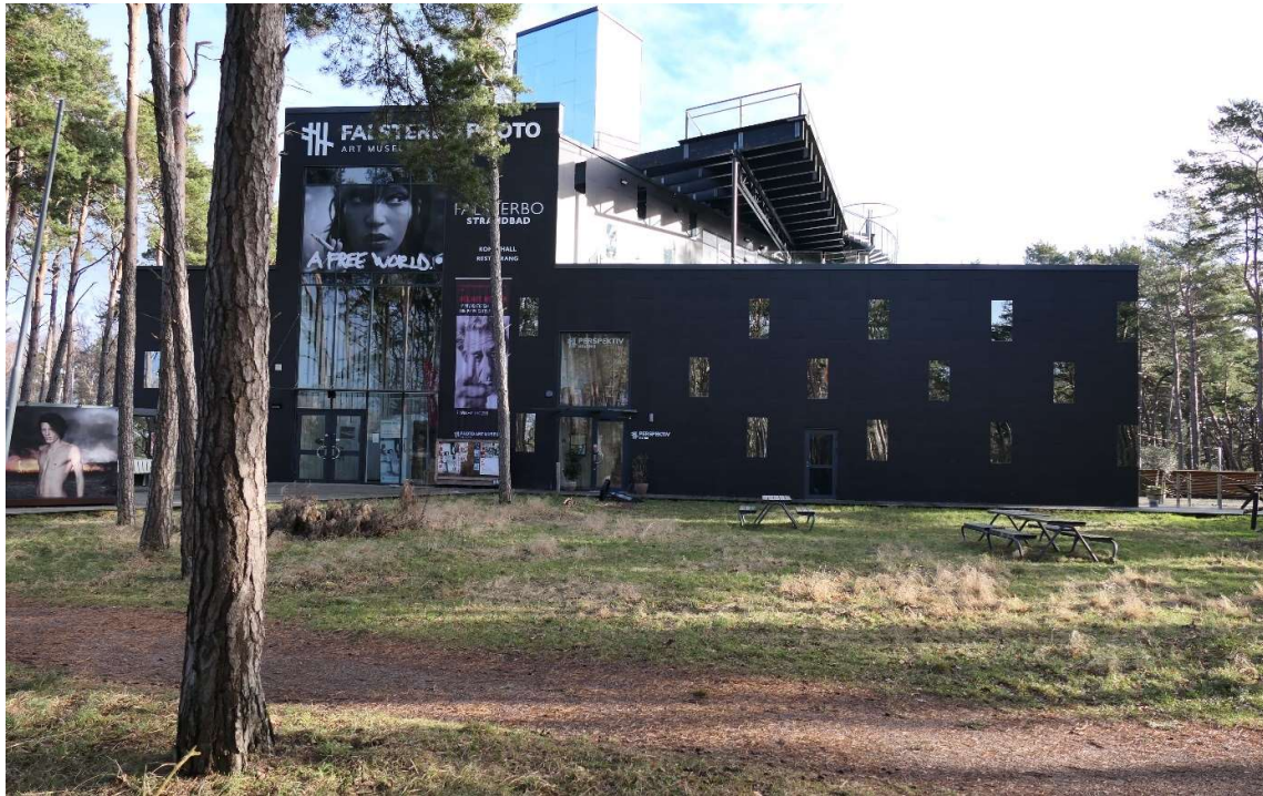
Huvudfasaden mot väster med nya fönster- och dörrpartier på vardera sidan om huvudentrén.
