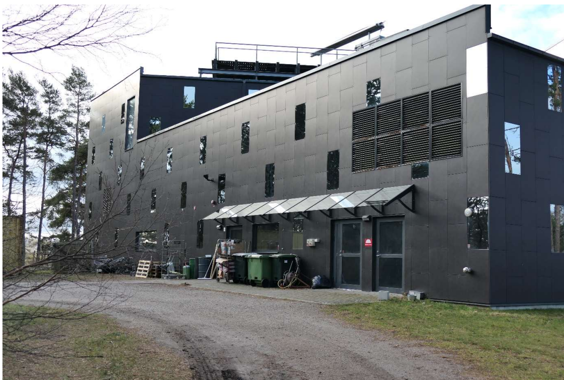
Fasad mot öster och entré till byggnadens sekundära utrymmen. Här har en ny dörröppning tillkommit och samtliga dörrar bytts ut, liksom skärmtaket.
