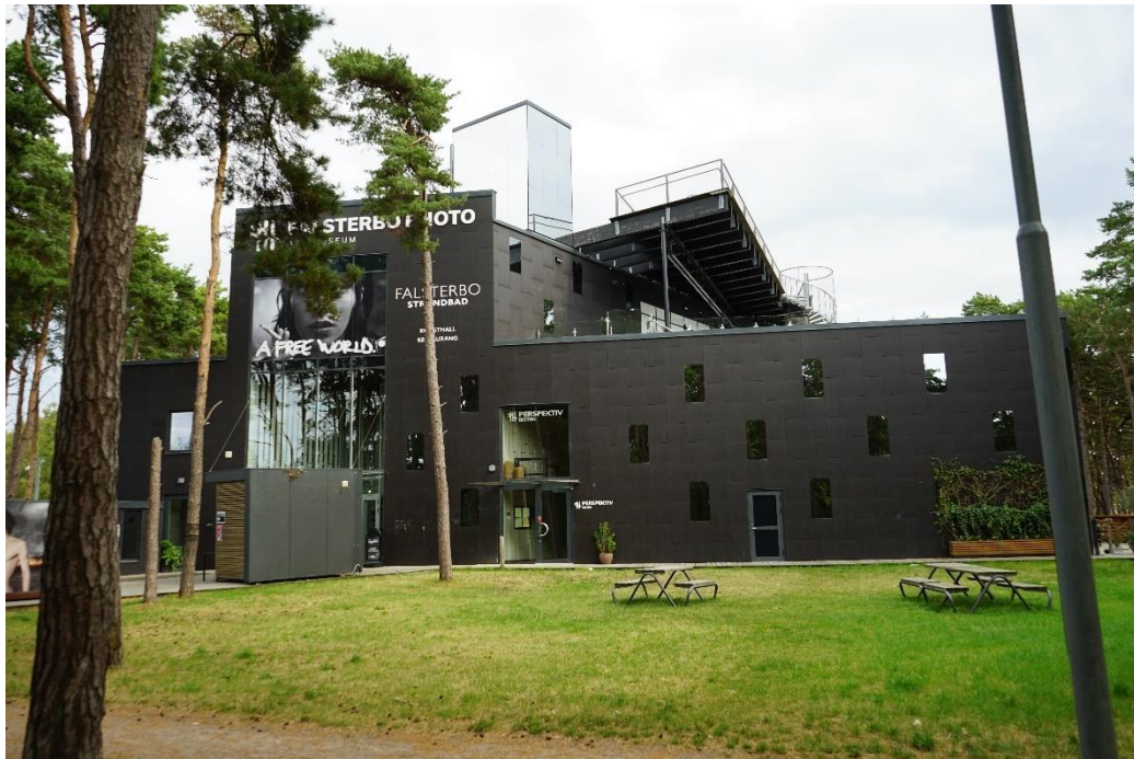
Befintlig byggnad. Vy från väst. Foto: FOJAB
