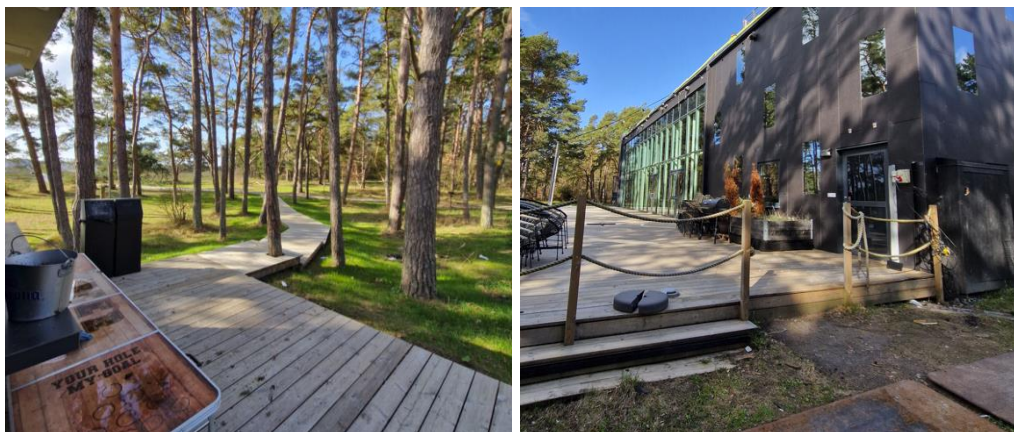
Trädäck runt befintlig byggnad. Foto: FOJAB
