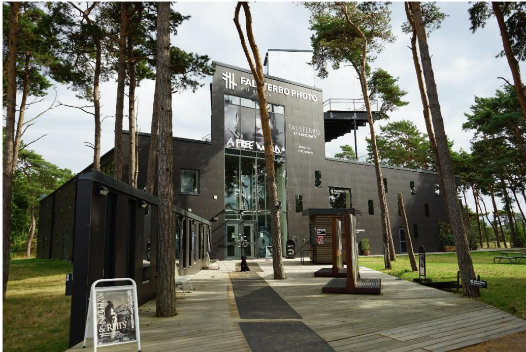
Befintlig byggnad sedd från nordväst. Foto: FOJAB
