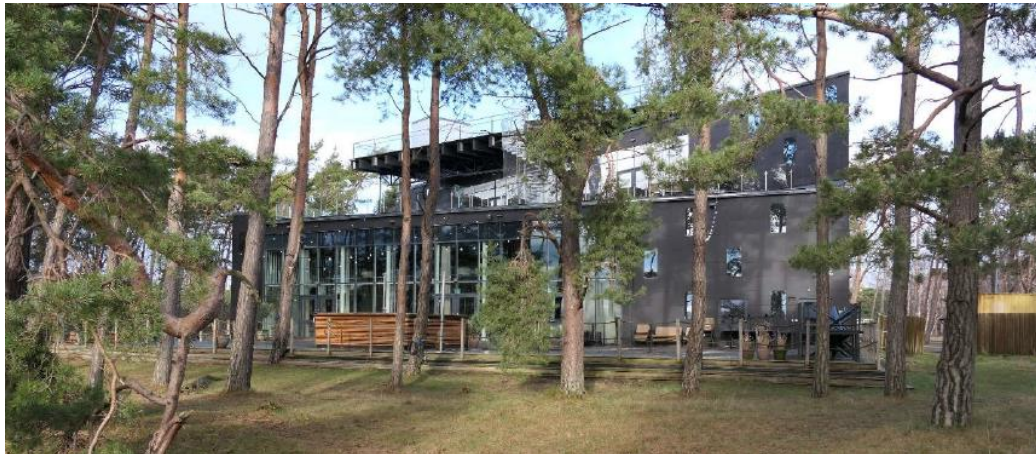
Befintlig byggnad. Vy från söder. Foto: Restaurera
