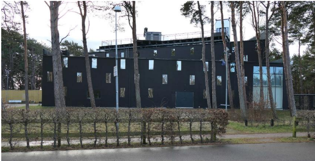
Befintlig byggnad. Vy från norr. Glaspartierna i liv med fasaden är ursprungliga, större fönsterparti och dubbeldörr är senare tillägg. Foto: Restaurera
