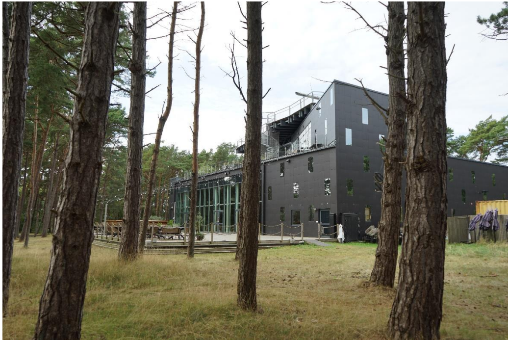
Befintlig byggnad. Vy från sydöst. Foto: FOJAB
