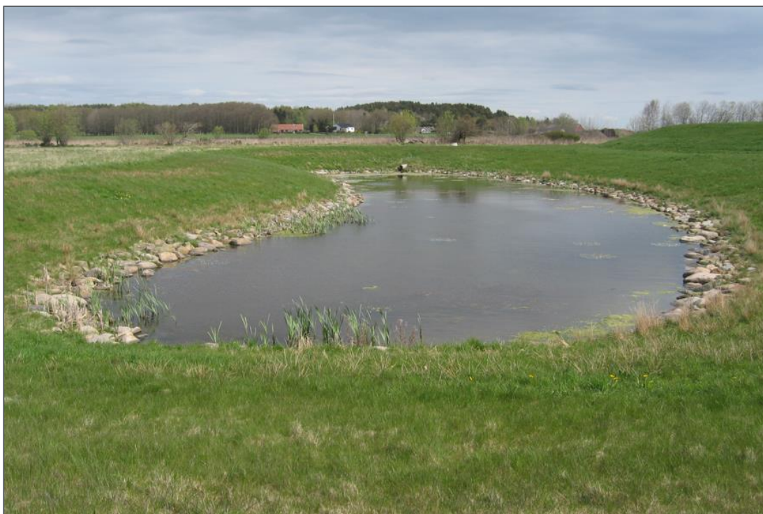
Figur 16. Exempel på en dagvattendamm (foto: Norconsult)
