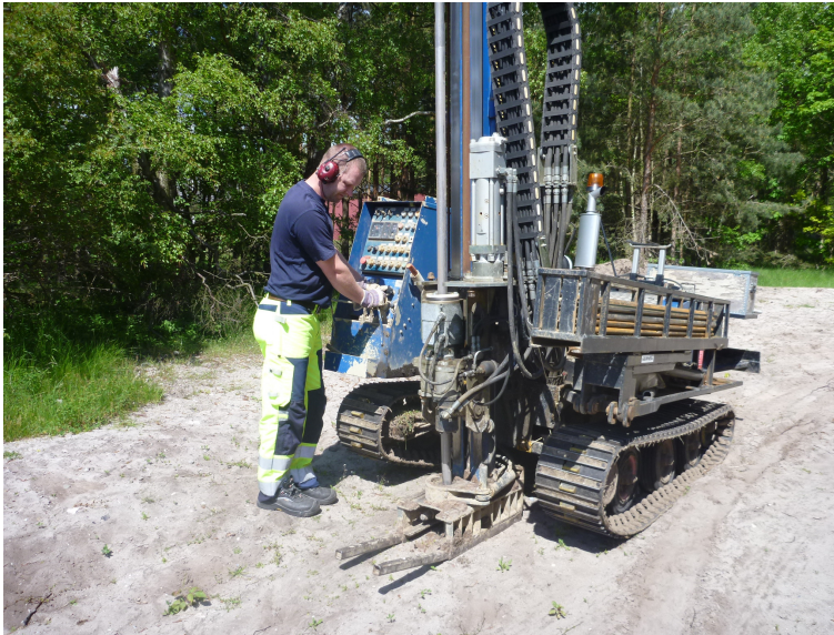
Figur 2. Provtagning med skruvborr monterad på bandvagn.
