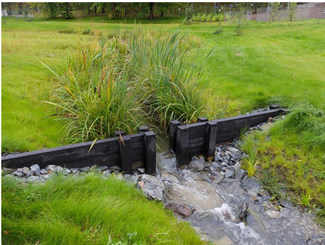
Figur 20 Avledningsstråk för dagvatten (med viss strypning) via gräsyta.
