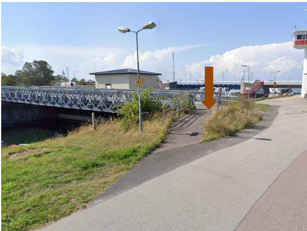
Figur 7 Möjlig anslutningsnivå på reservbron motsvarande +3,7 m (RH2000) visas med pil. Bild från Google Maps.
