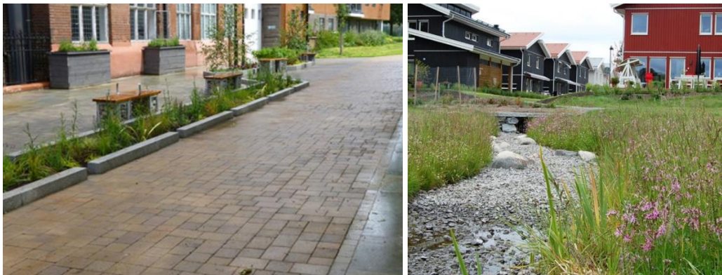
Figur 6 Exempel på ytlig avledning och fördröjning i planteringskanaler (t.v.) och ytliga svackdiken (t.h.)
