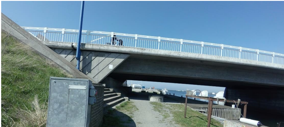
Figur 15 Grusväg under bron, vy från söder mot Västra Hamnplan. Källa: Mapillary 2018.
